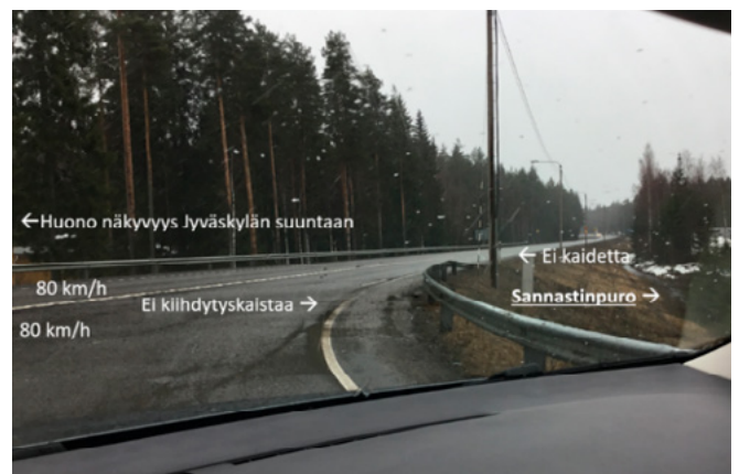
Kuva 64. Savilahdenkadun eritasoliittymä. Ajoneuvo liittymässä Jyväskylälle. Ei kiihdytyskaistaa tai kaiteita ja Sannastinpuroon on suora yhteys.
